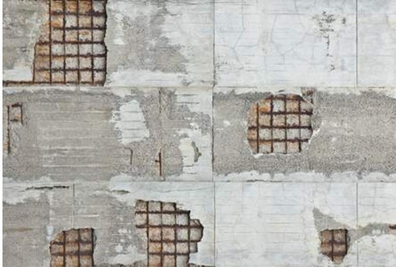
Betondeckung, Homogenität und Betonfestigkeit sind die wichtigsten Parameter, um festzustellen, ob Ihr Bauwerk gefährdet ist, Betonkrebs zu entwickeln (Korrosion, Rissbildung, Abplatzungen, Versagen usw.).
