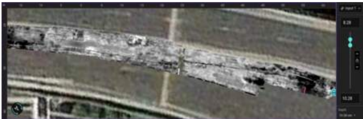
沥青混凝土 (A/C) 层之间的界面缺陷（分层）
