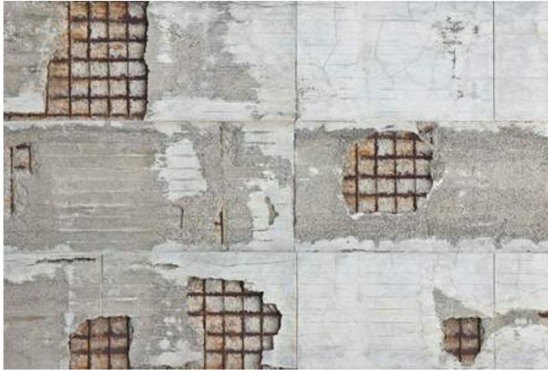
Il copriferro, l'omogeneità e la resistenza del calcestruzzo sono i parametri chiave per determinare se la struttura è a rischio di sviluppare il cancro del calcestruzzo (corrosione, fessurazione, scagliatura, cedimento...).
